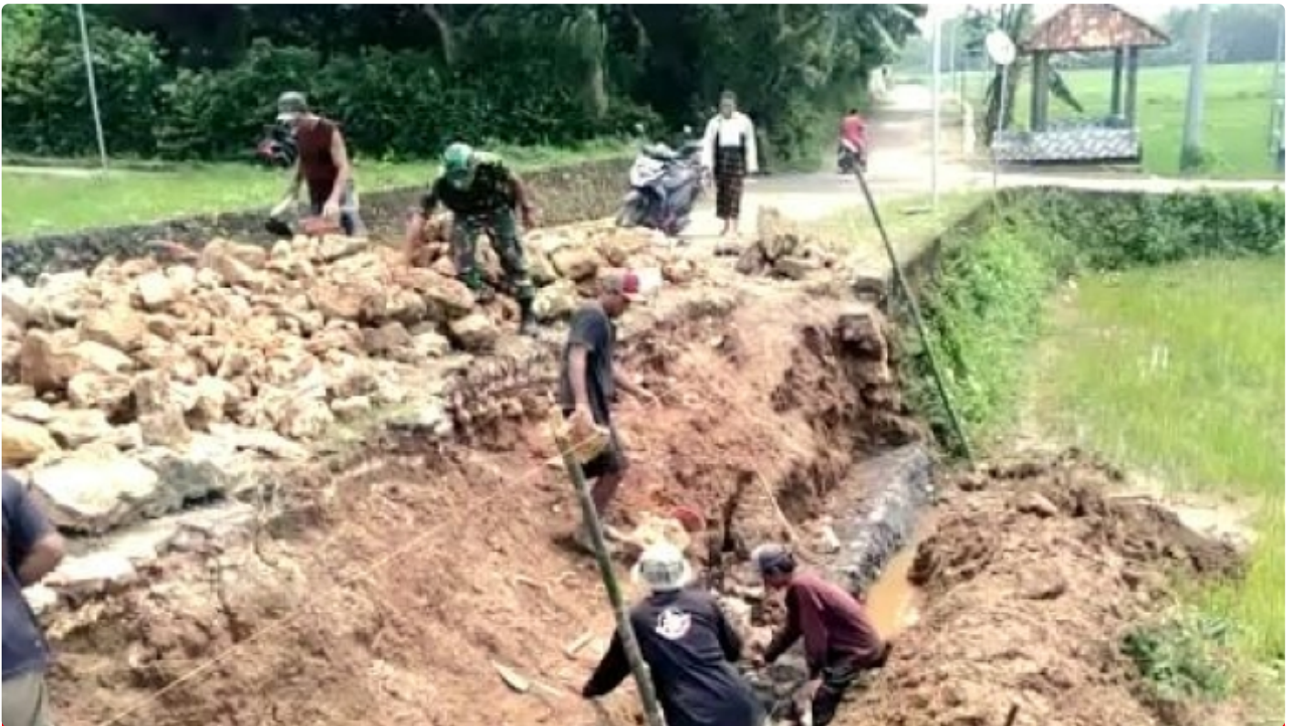
Karya Bakti pembuatan plengsengan penahan jalan
